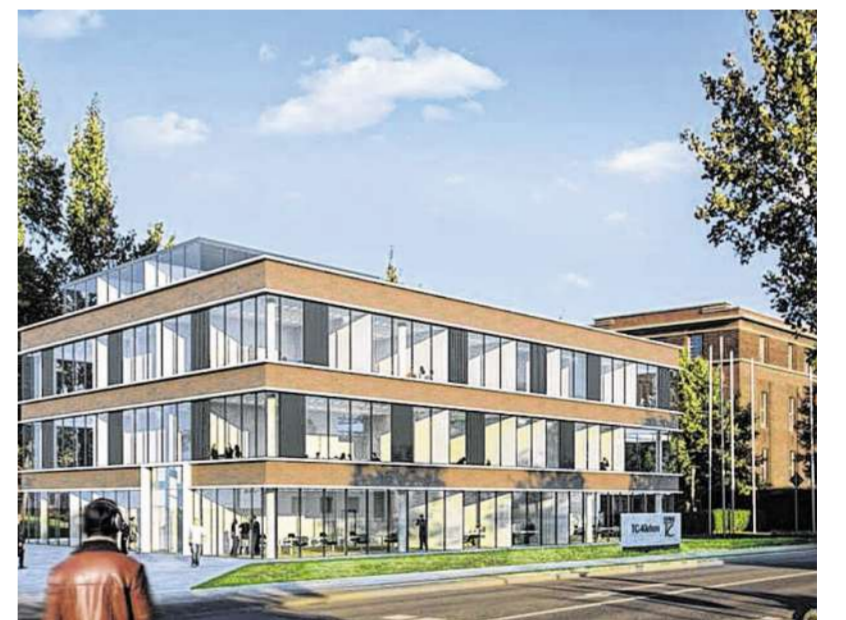
Ende des Monats ist erster Spatenstich zum Bau des neuen Gebäudes. Im Frühjahr 2018 soll der Neubau von den Mitarbeitern des TC Kleben bezogen werden. Simulation: Christian Montag
